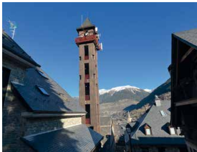
Una torre de Telèfonica al mig de Vielha.
