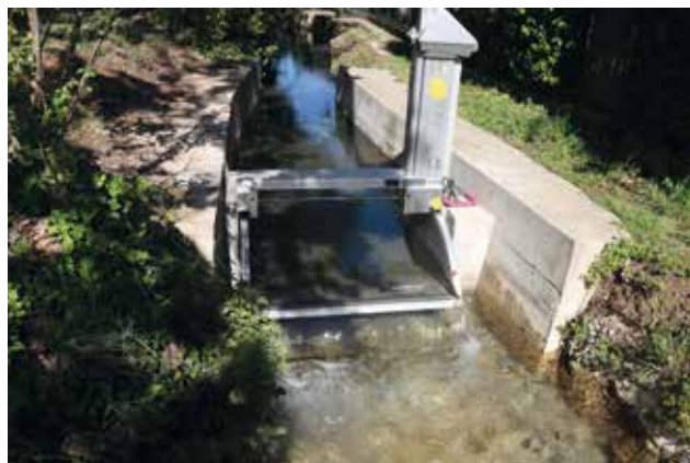
Una de les comportes automatitzades que ha instal·lat l'Ajuntament de Banyoles al rec major. Foto: ACN
