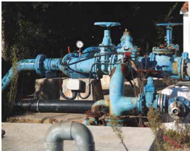
Detall d'un dels pous d'abastiment d'aigua de Vallirana.
