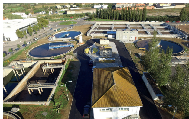
Vista aèria de la depuradora de Figueres. Foto: ACN
